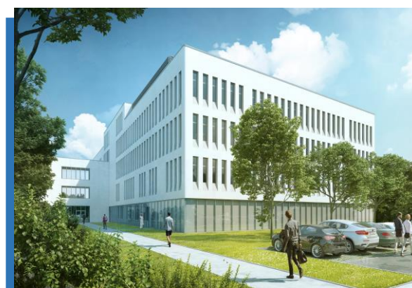
Budynek A plus, rok 2021
