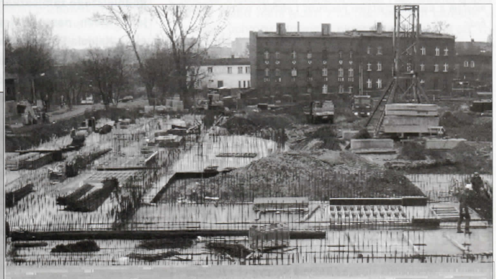
Rozpoczęła się budowa nowego budynku Śląskiego Centrum Chorób Serca
