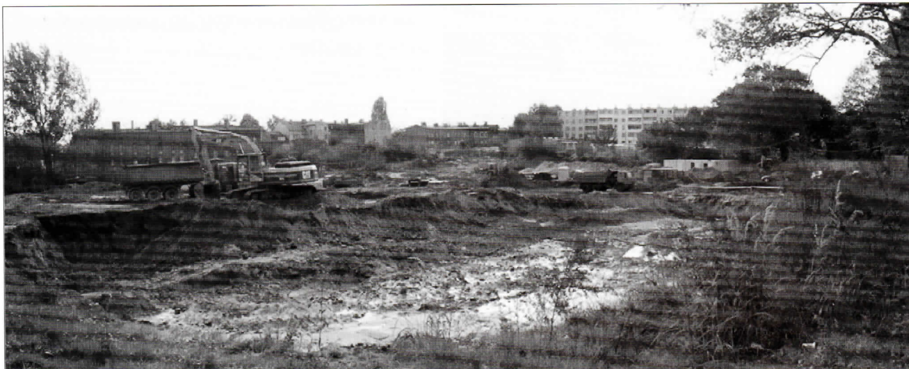
Tak wyglądał początek budowy
